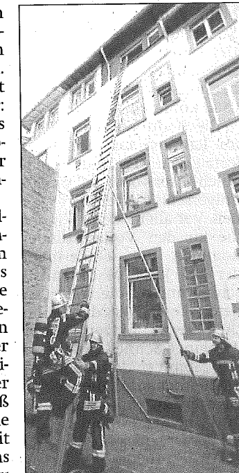
Im dritten Stock dieses Mehrfamilienhauses an der Mittelseestraße brannte es. • Foto: Georg
